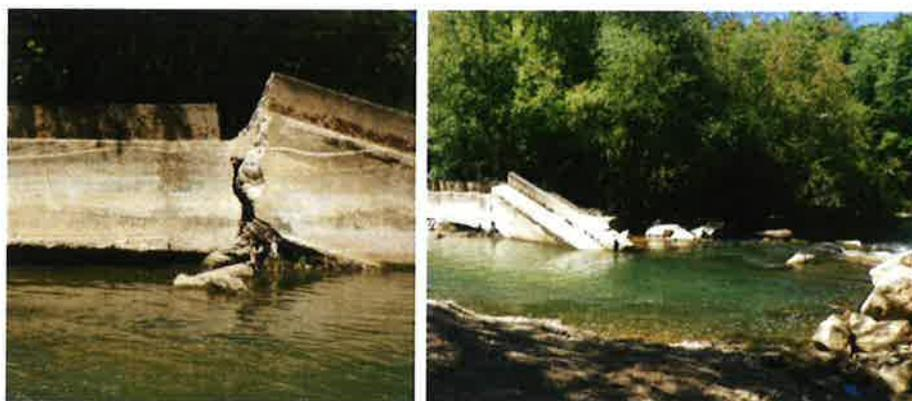
Figure 14. Rupture du vannage et brèche dans le barrage
