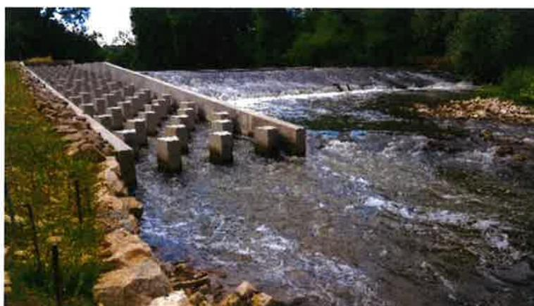
Figure 51. Rampe à macrorugosités régulièrement réparties sur l'Allan au droit du barrage de Méziré (90)
