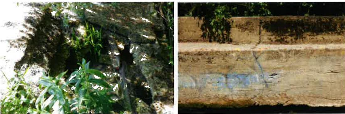
Figure 16. Cavité dans le coursier aval et fissuration du parement amont
