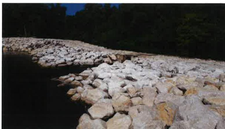
Figure 29. Exemple de barrage en encrochements appareillés
