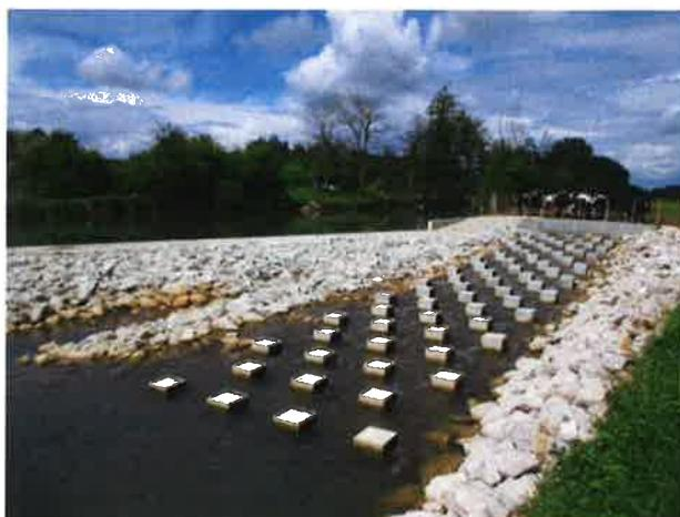
Figure 50. Rampe à macrorugosités régulièrement réparties sur la Bèze à Vonges (21)
