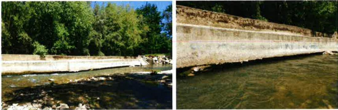
Figure 15. Affouillement généralisé du barrage
