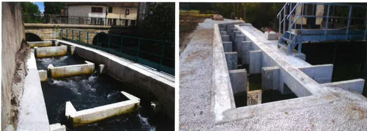
Figure 47. Exemples de passes à bassins successifs – Passe à poissons à double fente de Mirebeau-sur-Bèze (21) (à gauche) et passe à poissons à échancrures de Couternon (21) (à droite)
