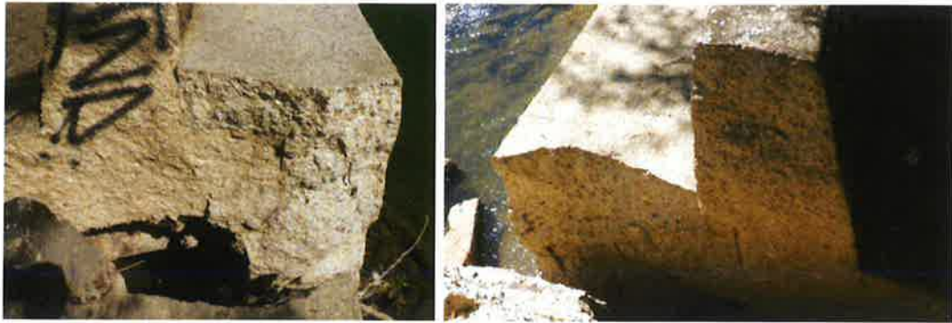
Figure 22. Structure interne du béton constitutif du barrage
