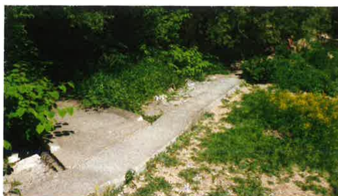
Figure 5. Passe à canoës du barrage de Longvic
