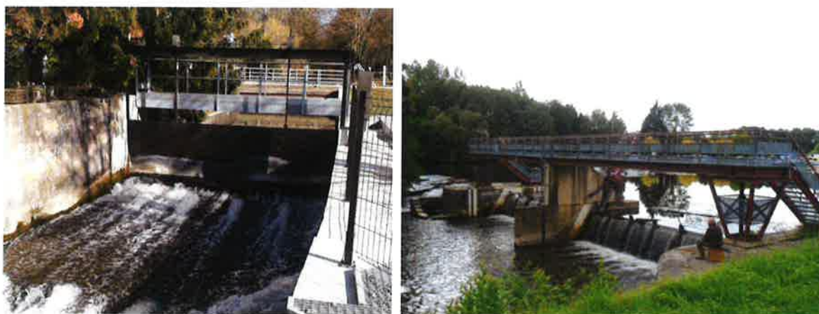
Figure 57. Exemples de bouchures de type « vanne levante » sur le barrage de Couternon (21) (à gauche) et de type « clapet » sur le barrage de Vermenton (89) (à droite)
