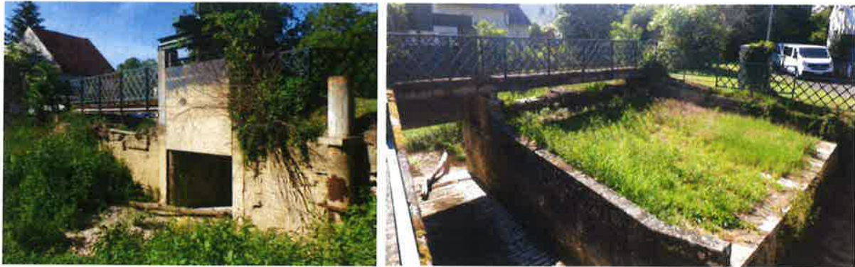
Figure 9. Vue amont (à gauche) et vue aval (à droite) de l'ouvrage de décharge de la mairie
