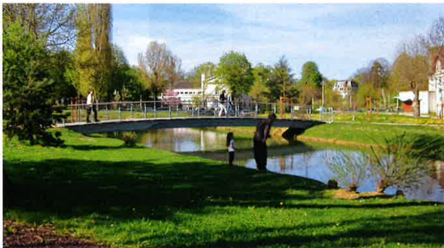
Passerelle - Axe Vert - reliant l'écoquartier au centre-bourg par le Parc de la Mairie
