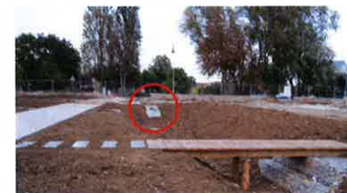
vue du déversoir de la noue de l'écoquartier
